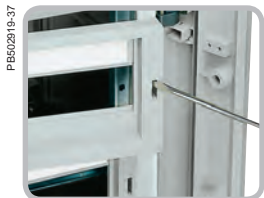
Фрагмент монтажа передней панели
