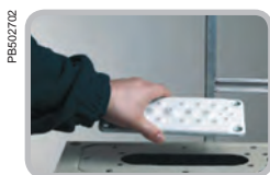
Установите мембрану в стандартный вырез
